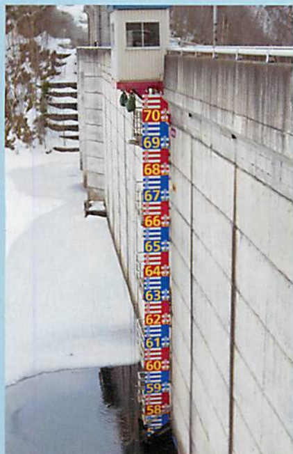
(上) 危険レベルが一目で分かる洪水痕跡機能付量水標 (左) 斜めからでも見やすいデザイン量水標
