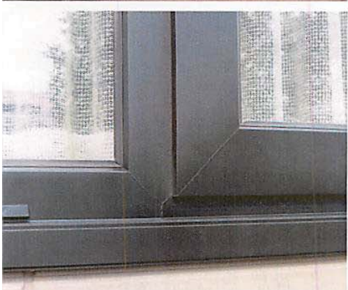
リペアする前の樹脂サッシ(上)がNJSP工法で蘇った(下)。
