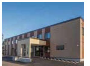
サービス付き高齢者向け住宅「らくら拓北式番館」
