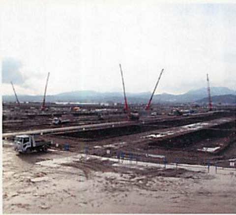
建設が進む工事現場
