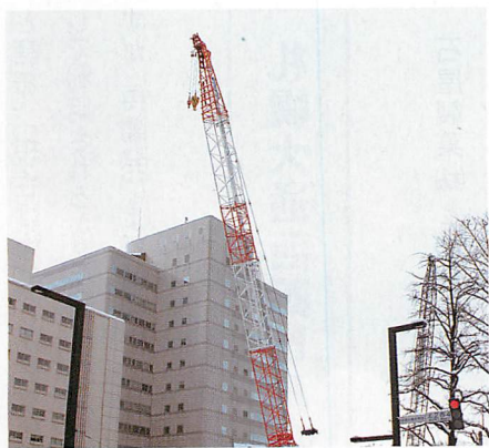
クレーン車による工事が進む現地
