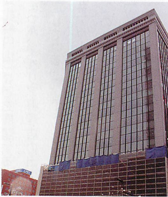
建設が進む現地
