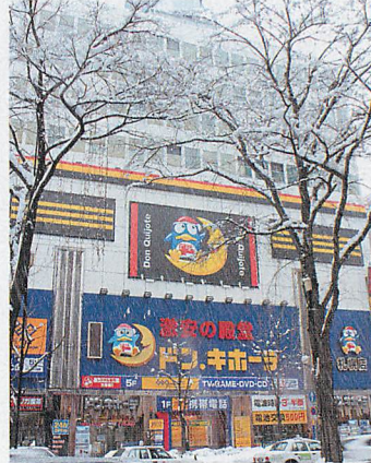
解体予定のサンデパートビル
