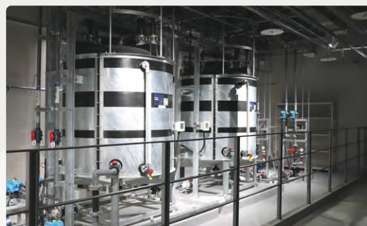
▲水の循環のラボ 人工海水を製造するためのプラント
