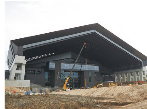
エスコンフィールドHOKKAIDOの屋根の防水
