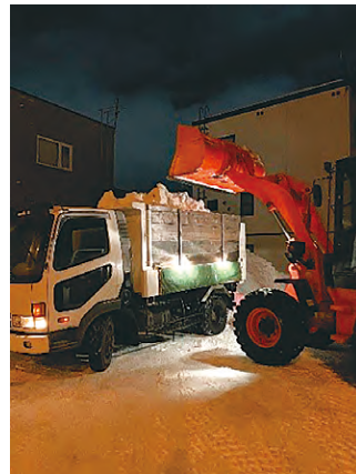
除雪作業の様子
