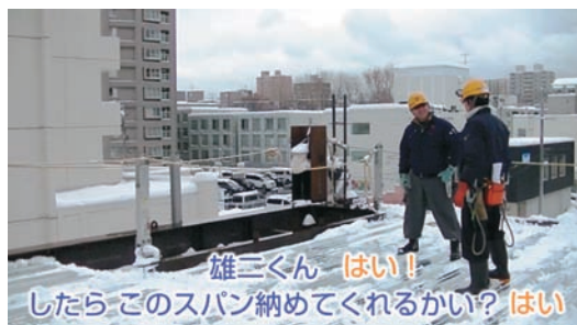
作業指導中の様子：HP「ボクラノシゴト『デッキプレート施工』」より
