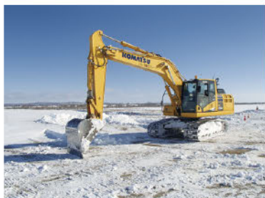
【MCによる施工】
