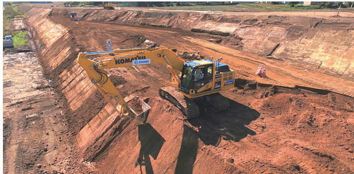
MCバックホウ重機による盛土法面整形
