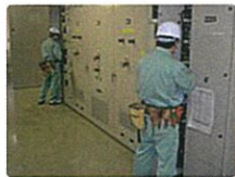
電気設備更新工事
