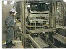
立体駐車場据付工事
