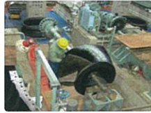
排水機場ポンプ・モータ更新工事
