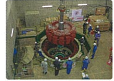
水力発電所諸工事
