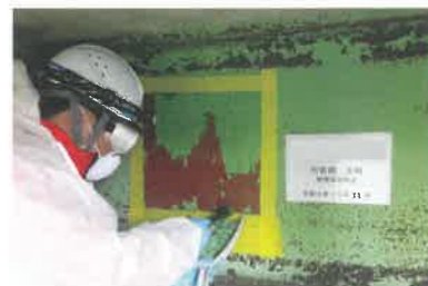
林道橋梁塗膜調査
