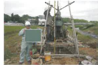
ボーリング調査
