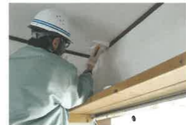
アスベスト調査
