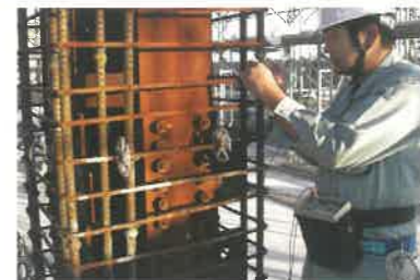
超音波探傷検査
