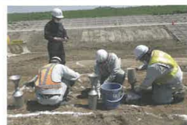
現場密度試験
