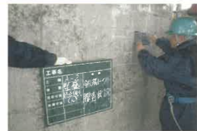
鉄筋レーダ探査
