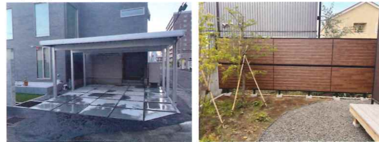
【施工例】カーポート設置、アスファルト舗装、フェンス設置
