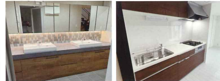
【施工例】洗面化粧台・システムキッチン交換
