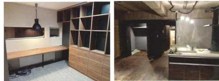
【施工例】マンション1室フルリフォーム
