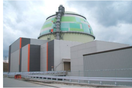
泊原子力発電所(泊村)
