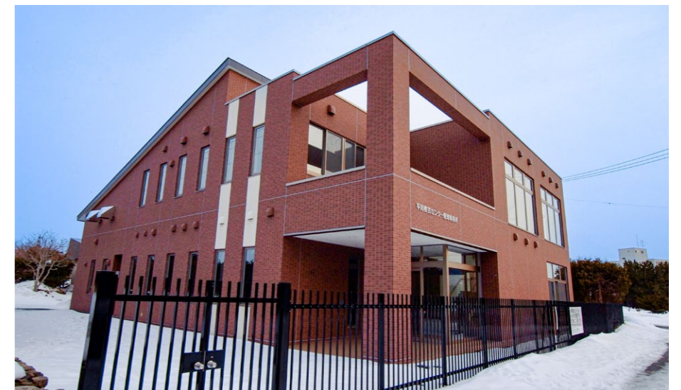
平岡樹芸センター管理事務所(札幌市清田区)
