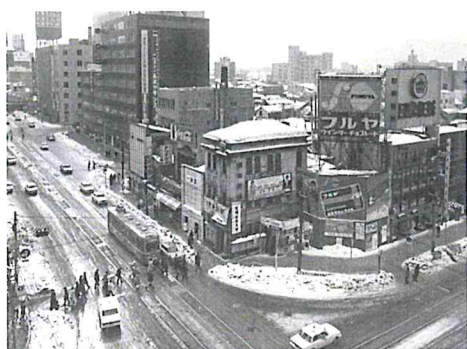
4丁目プラザ 建築前
