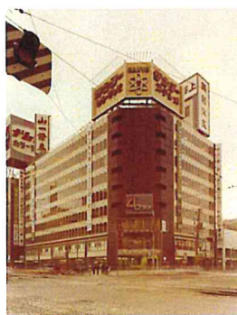
4丁目プラザ 竣工
