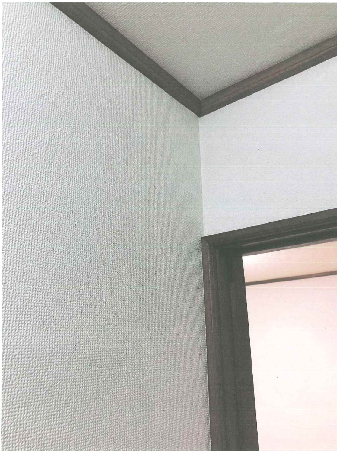
壁紙チタンクロスコーティング施工後。既存壁紙の質感を活かしながら、明るく清潔感のある壁面へ再生。
