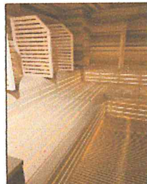
サウナ室：隔壁で区切られており、サウナストーブ付近に送られた空気は温められ、頭上から床下の排気口に送られる。
