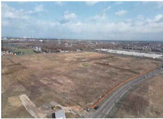
▲2023 年 4 月 造成工事開始時
