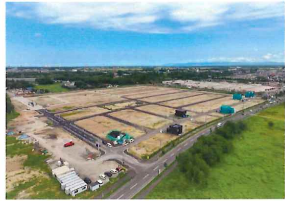
▲2024 年 7 月 部分竣工時（154 宅地分）
