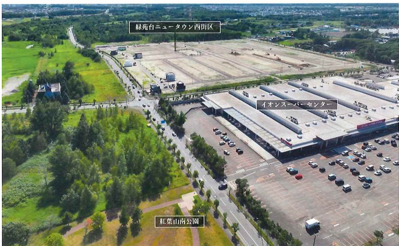
▲本プロジェクト空撮写真
