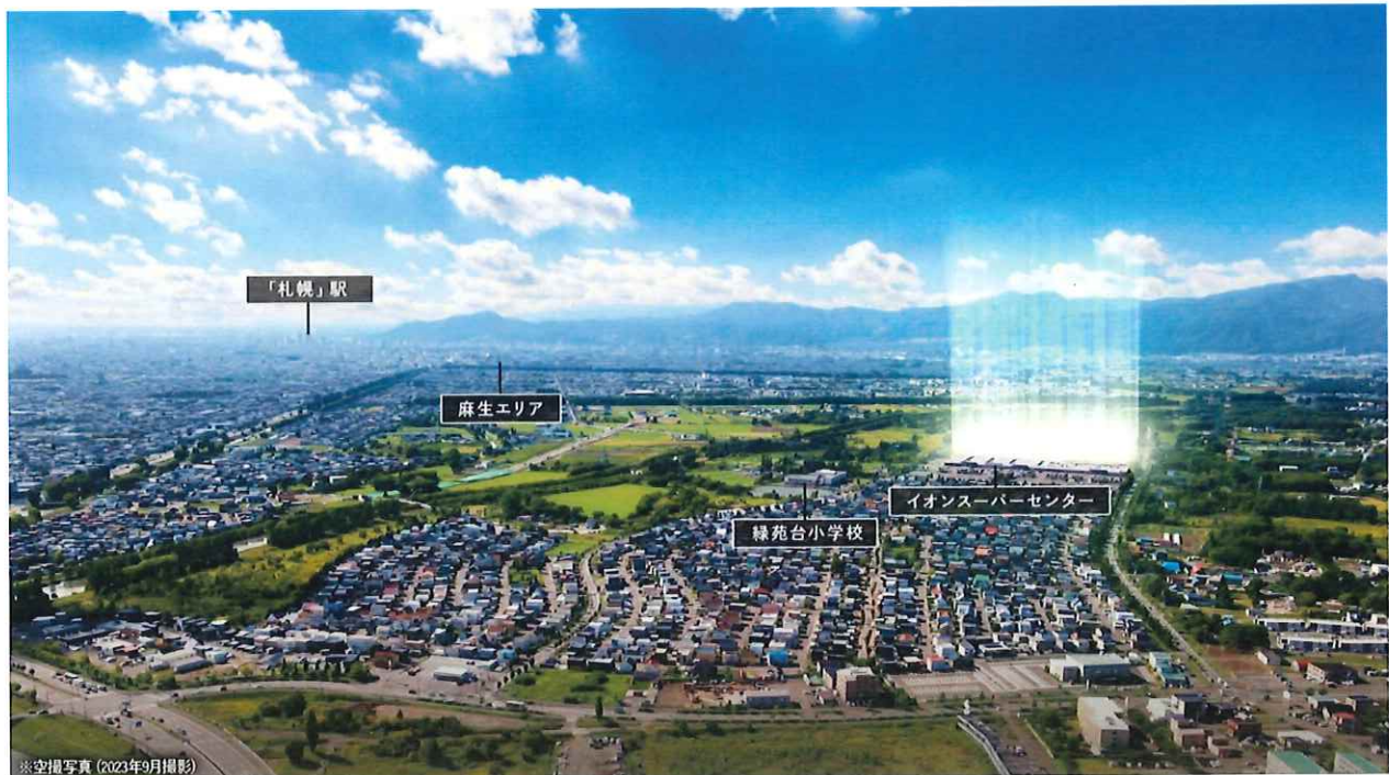
▲本プロジェクト空撮写真
