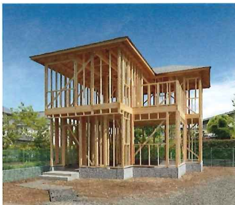
積水ハウスが請負う S（基礎・躯体）
