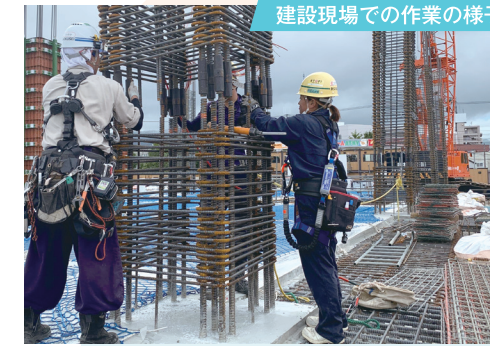
建設現場での作業の様子
