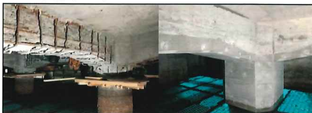
栈橋補修前（研り後）
