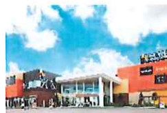
第1期 クローバー・モール 北エントランス
