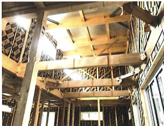
施工中のスーパーウォールパネル
