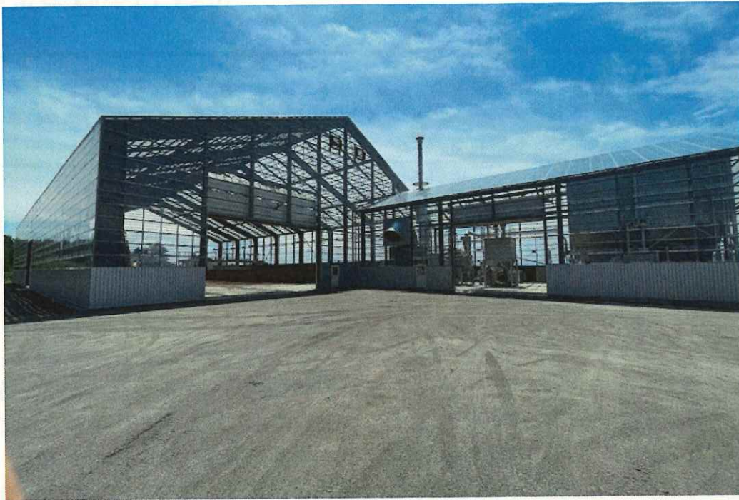
■新たに稼働した施設外観
