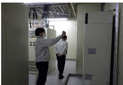
空調設備設置状況の調査
