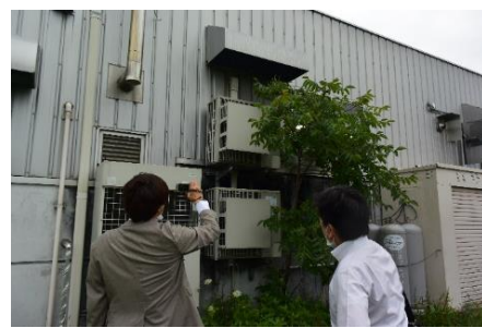
屋外設備の調査
